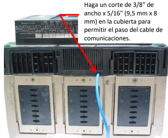
Haga un corte de 3/8" de ancho x 5/16" (9,5 mm x 8 mm) en la cubierta para permitir el paso del cable de comunicaciones.
