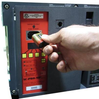
Retire la batería vieja e instale la nueva batería CR-P2 de litio y 6 V. Coloque nuevamente la cubierta de la batería.
